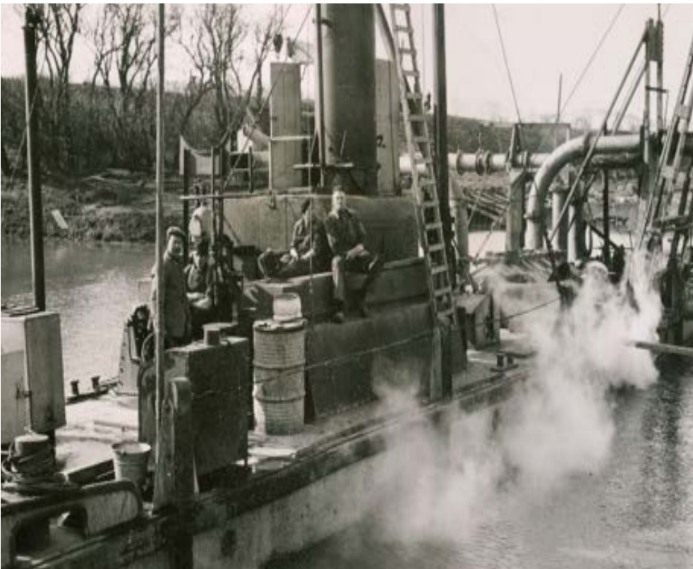
Aanleg van de tankgracht nabij Maasdijk
